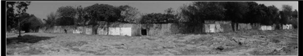
鳳山舊城-西城僅存之城垛內牆
